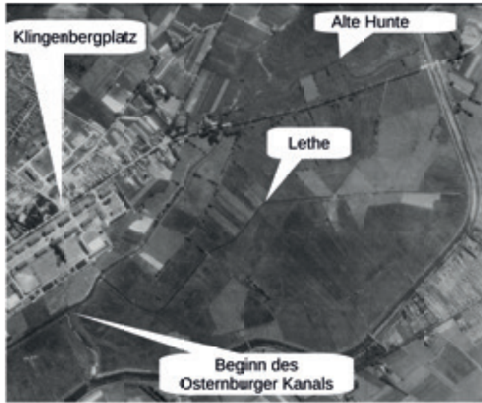
Auf dieser Luftaufnahme aus dem Jahre 1942 ist deutlich zu erkennen, dass der Osternburger Kanal nicht bis zum heutigen Tungalner Abschlagswerk reichte. Deutlich ist noch zu erkennen, welchen Verlauf das alte Huntebett vor der Begradigung vor 1964 hatte.
